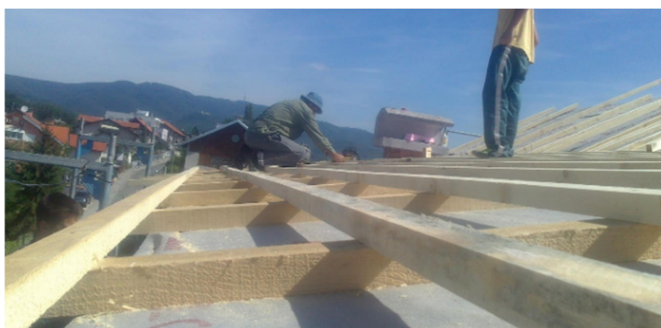
Slika 38. Letve i kontraletve na foliji
