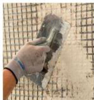
Ugradnja FRCM sustava
