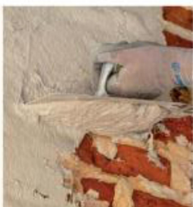
Žbukanje reparaturnim mortom
