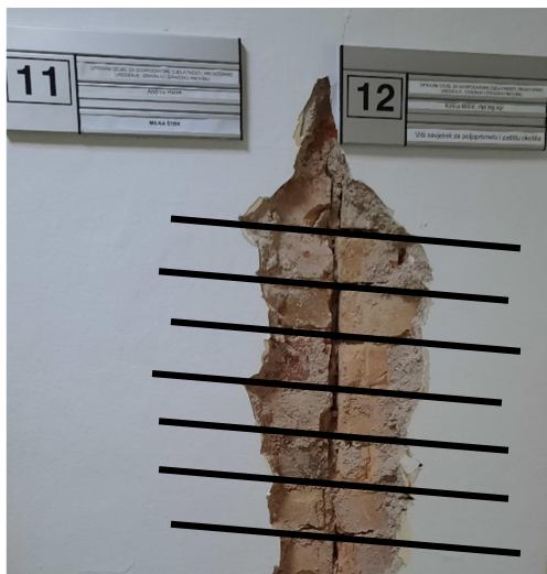
Slika 35. Preklopljene sljubnice koje se saniraju
